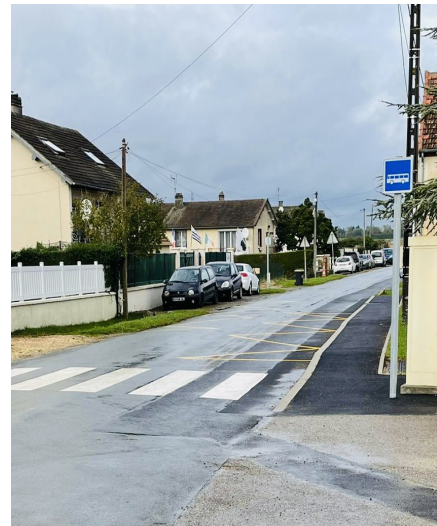
Création d'un trottoir pour sécuriser l'arrêt de bus « Mary Cassatt »
